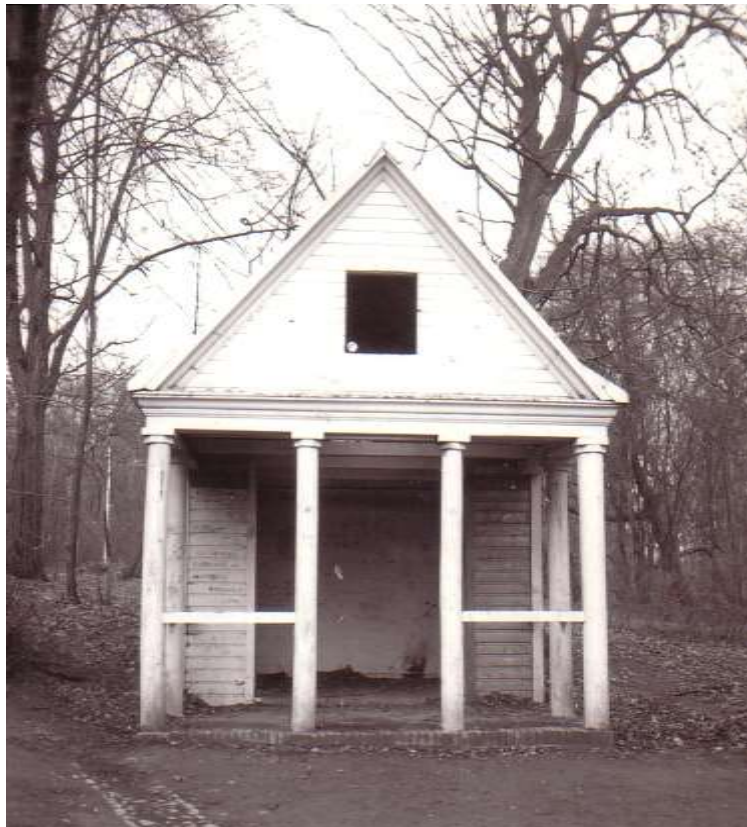
Der Raabesche Pavillon am Standort der alten Eierhütte im Jenischpark Foto 1980 (Zg)
